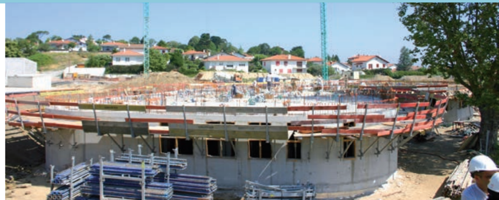
Biarritz - Quartier Kléber - Construction de 382 logements
