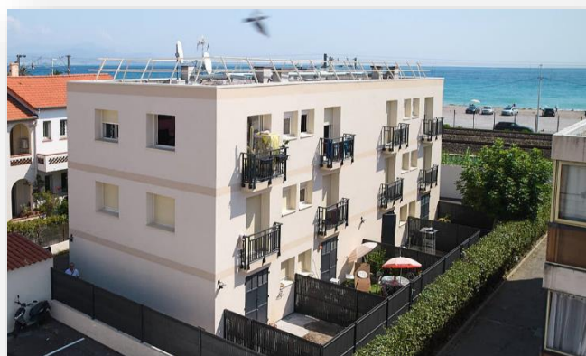
Résidence « Le Sole Mio » 21 logements réhabilités - Etiquettes énergétiques passées de F à B
