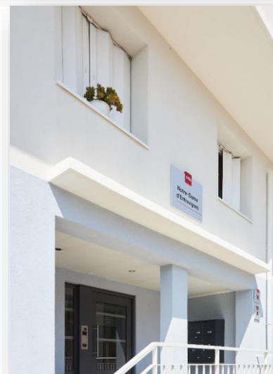
Résidence « Notre Dame d'Entrevignes » 24 logements réhabilités - Etiquettes énergétiques passées de E- F à B
