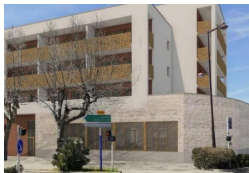
Résidence autonomie « La Fontaine de Font-Vieille » Architecte One Way Architectes
